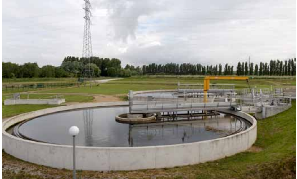
Station de traitement des eaux usées de Honfleur
