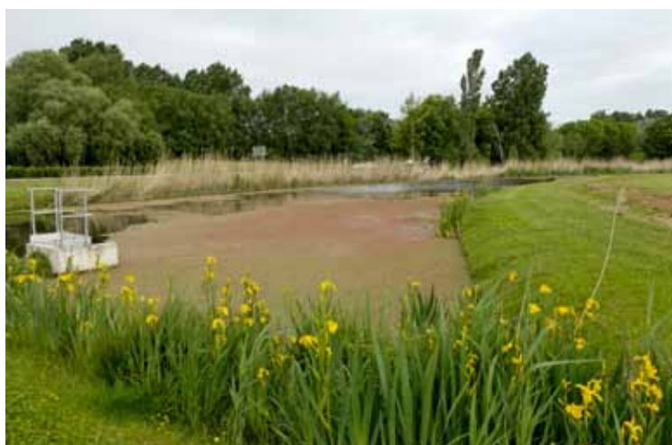
Zone de rejet végétalisée d'une station de traitement des eaux usées
