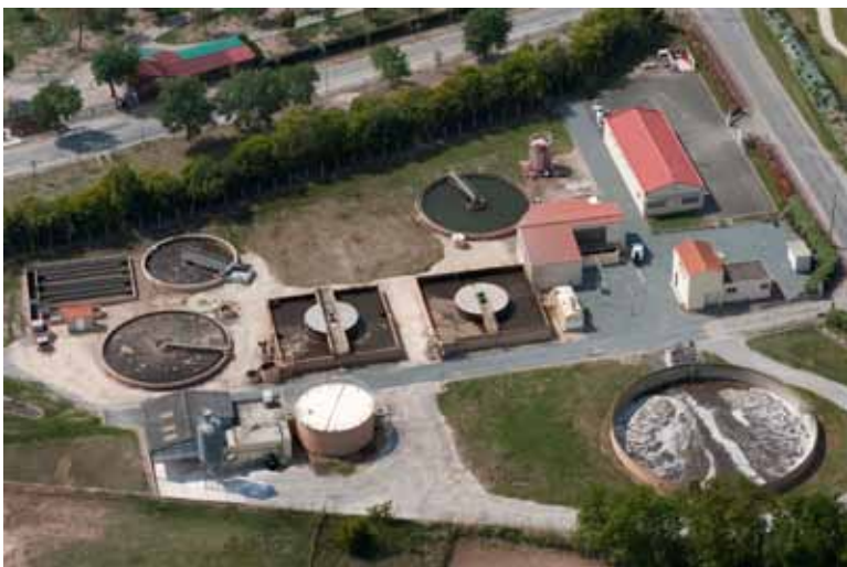
Station de traitement des eaux usées
